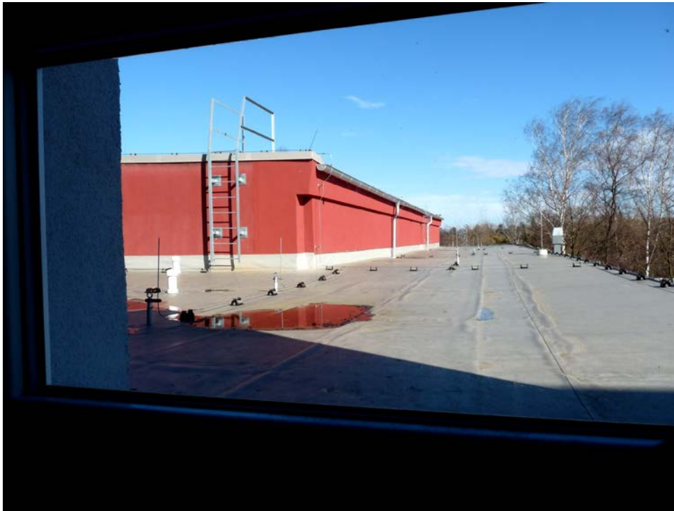
Obr. č. 2 – část opravené střechy
